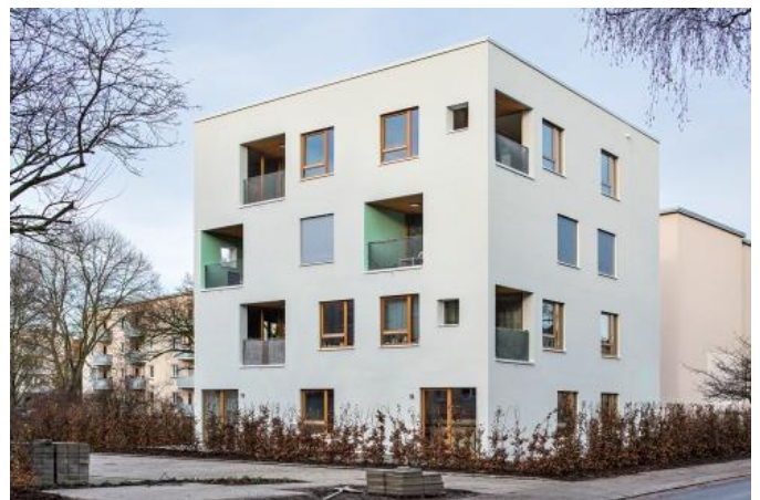
Der „Bremer Punkt“ ist als modulares Baukastensystem konzipiert und besteht aus überwiegend vorgefertigten Bauteilen. Ein Erschließungskern aus Stahlbeton steift das Gebäude aus. Foto: Nikolai Wolff & Kay Michalak, Fotoetage.
