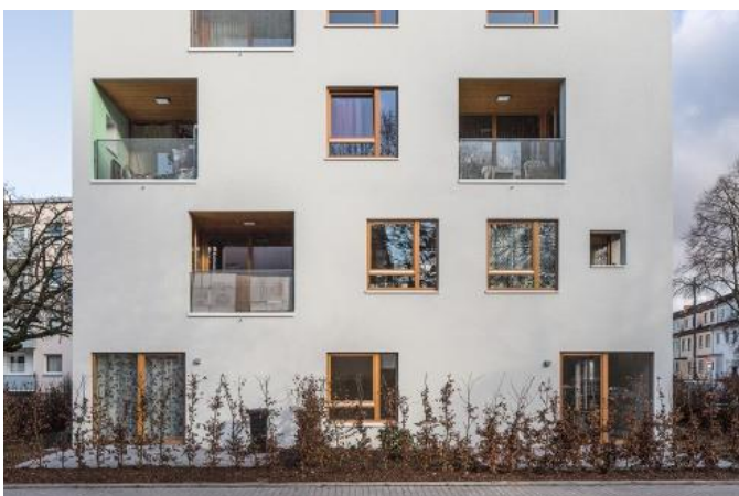
Die ersten Gebäude auf einer Grundfläche von knapp 14×14 Meter wurden im Frühjahr 2017 fertiggestellt. Foto: Nikolai Wolff & Kay Michalak, Fotoetage.
