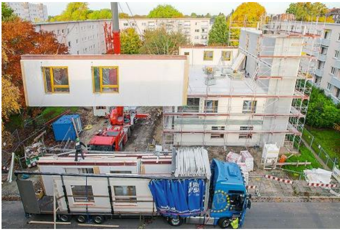
Montage der Fassadenelemente. Foto: LIN Architektur.
