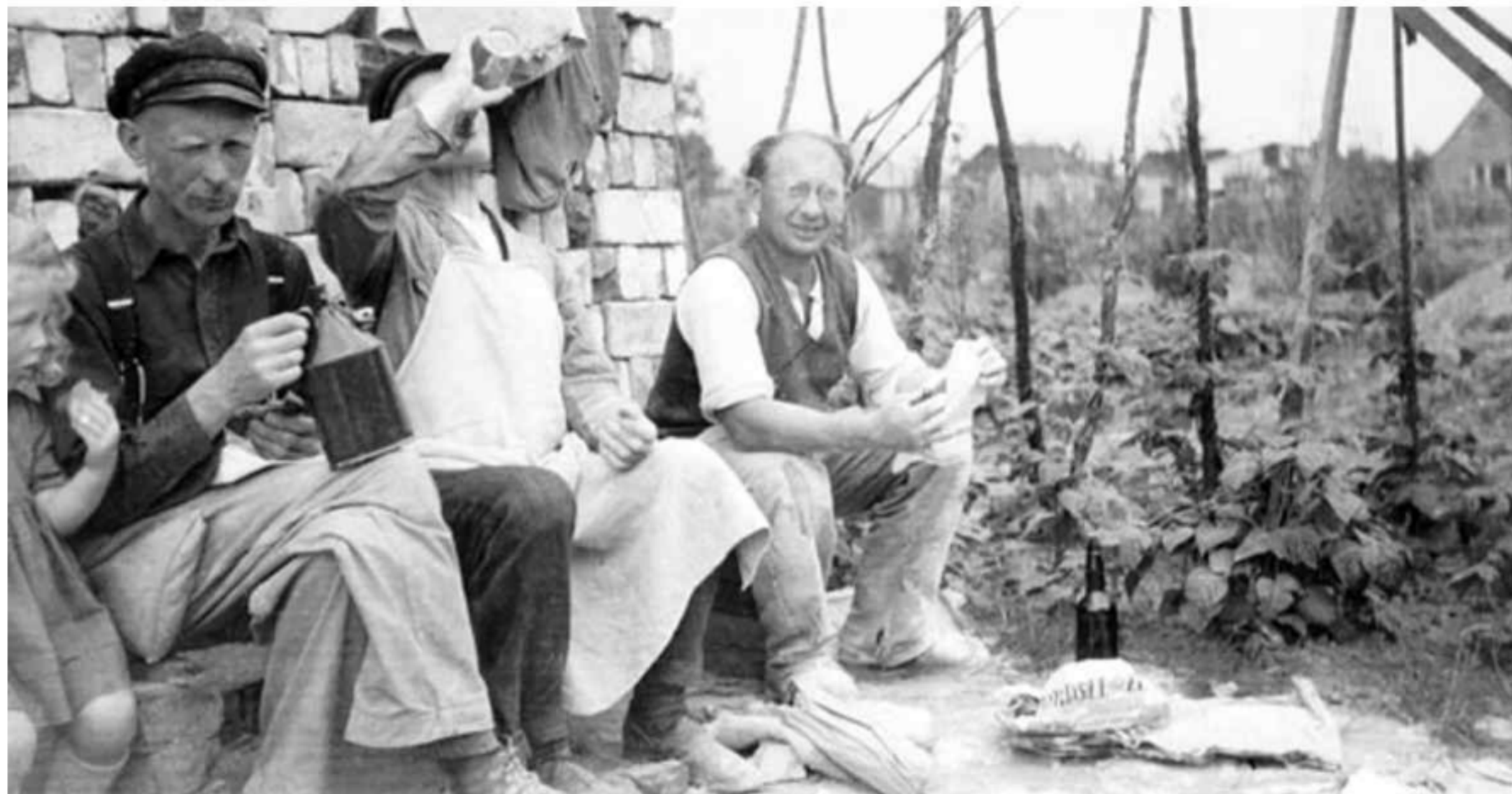
Pause beim Bau eines neuen Kaisenhauses 1949: Nachbarn, Freunde und Verwandte packten damals mit an.
