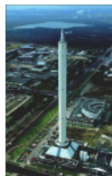
Kein Minarett: Fallturm von Rosengart
