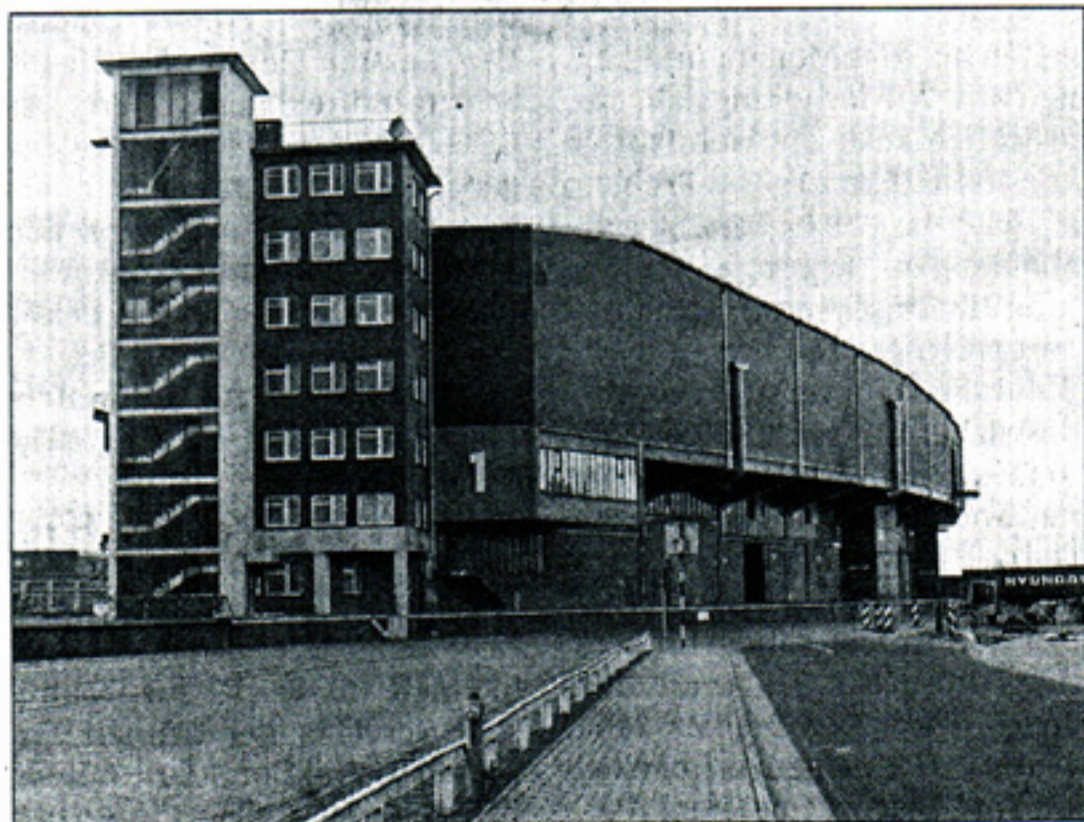
Bremens eindrucksvollste Hafenschuppenfassade: Schuppen 1 am Europahafen FOTO: ROLF HÖHMANN
